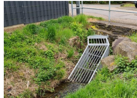
Einlaufbauwerk Auf'm Mühlenspitz (Heimbach-Weis)
