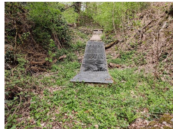
Melsbacher Floß: Einlaufbauwerk
