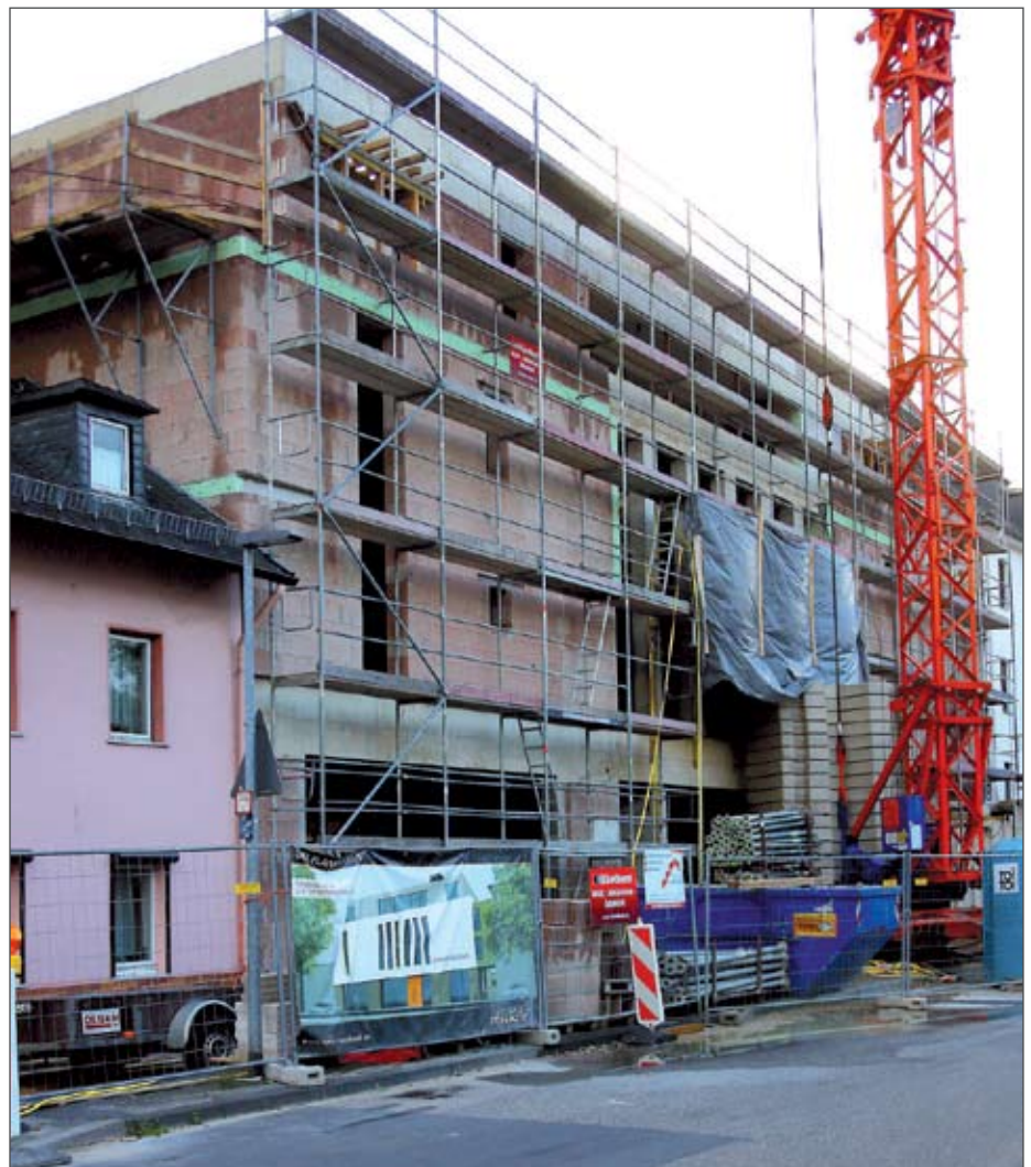
Das neue Gebäude soll im kommenden Frühsommer fertig sein.
